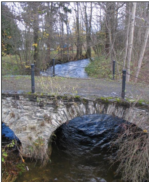
Niva řeky Moravice v prostoru EVL Niva Moravice se starým kamenným mostem v Dolní Moravici
