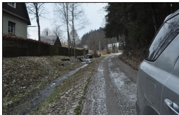
Pohled na přístupovou komunikaci, vlevo koryto toku
