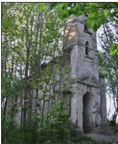
Kaple sv. Anny v zaniklé osadě Hutov
