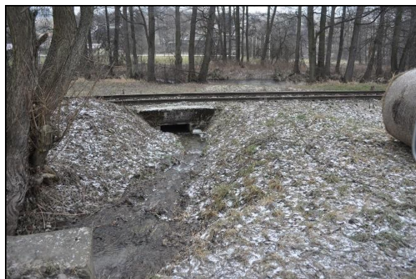
Pohled na propustek pod železnicí, za železnicí se nachází vodní tok Moravice
