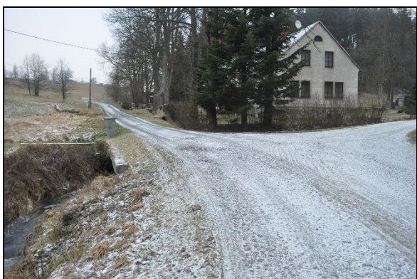
Pohled na přemostění vodního toku (kapacitní úsek)
