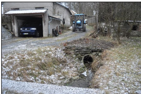
Pohled na konec zatrubnění v zástavbě
