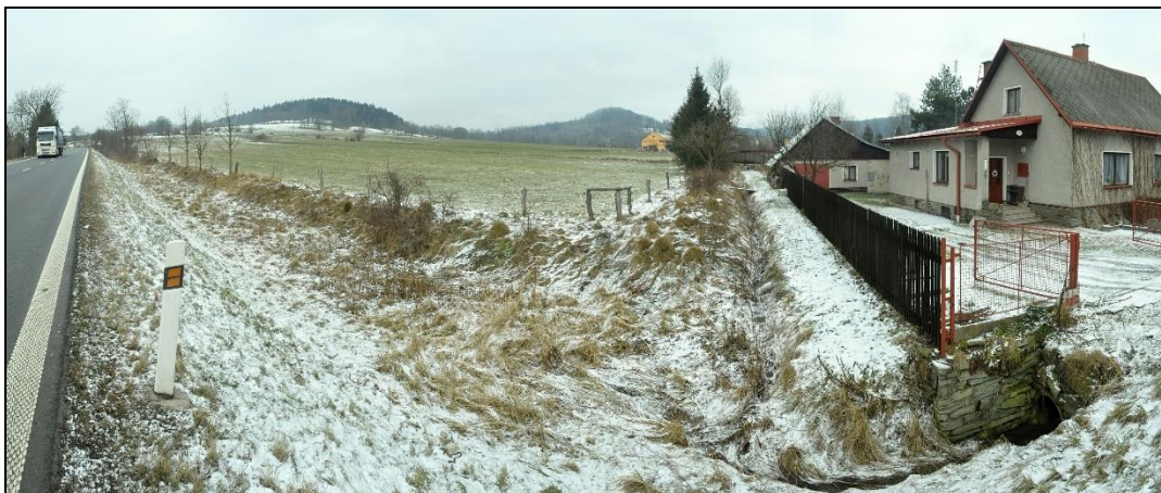
Panoramatický pohled na celou problémovou lokalitu, podél silnice I/11 a podél zahrady jsou svodné příkopy, které odvádějí vody směrem k zatrubnění
