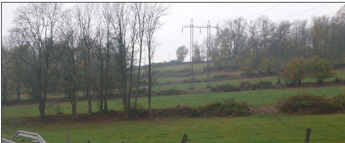
Liniový průsek pro nově realizované vedení VVN 400 kV přes kamenice porostlé dřevinami mezi Horním Městem a Tvrdkovem
