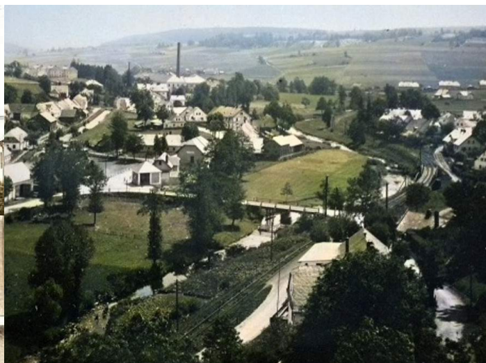
Obr. č. 3: Historická fotografie mostu (nedatováno); zdroj: podklady k soutěži
