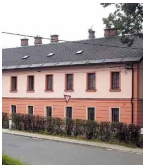
Pokračuje revitalizace bytových domů
