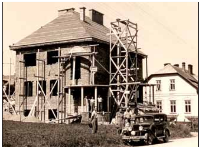
Stavba české menšinové školy, 9. července 1938
