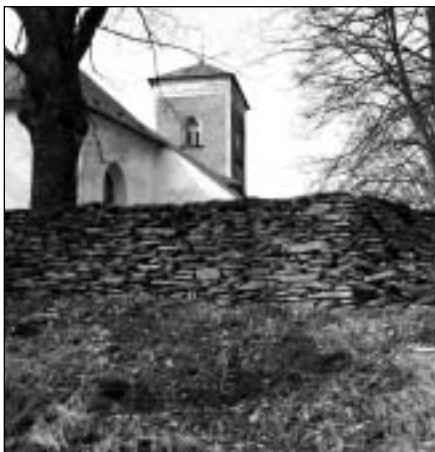
Renesančně-barokní zeď hřbitova v Lomnici u kostela sv. Jiří. Vpravo v rohovém výklenku hřbitovní zdi byly spalovány luteránské knihy, vykopané mrtoly vampýrů i ďáblem posedlá halapartna ponocného Ganssa.
