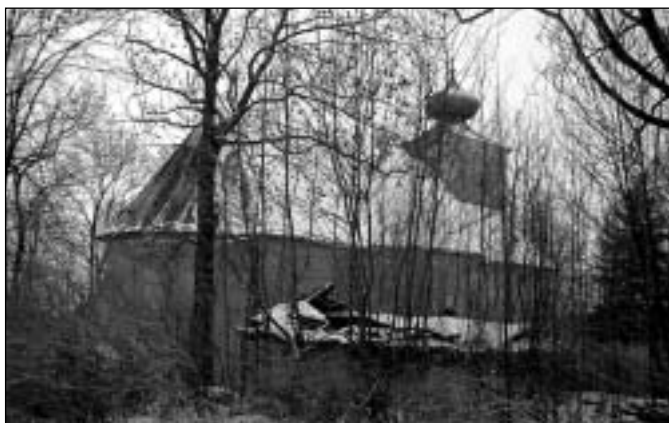
Kostel z východní strany
