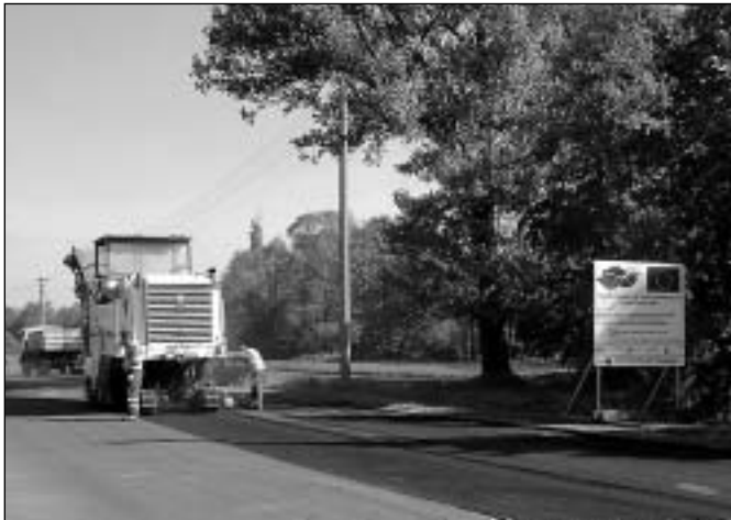
Zahájení stavby průtahu Frýdlantem
