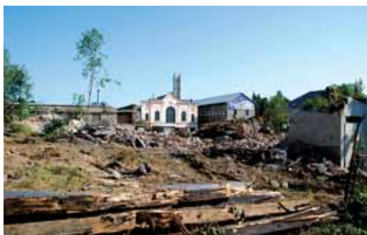
Hedva Prima bourá zchátralé budovy na Opavské ulici
