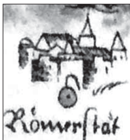
Hranolovitá, věžovitá Dolní brána na vedutě města (Fabricius 1569)
