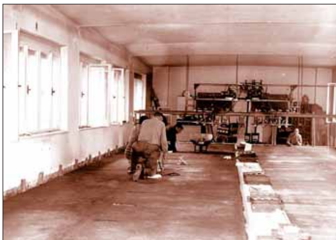
Rekonstrukce na čtyřdráhu byla zahájena v r. 1981
