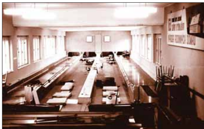
Konec srpna znamenal i konec hrubých stavebních prací. Na dráhy byl položen sadurit, byly dokončeny mantinely a instalovány se nové nahazovací desky
