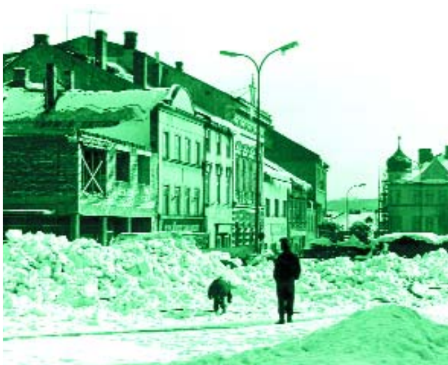
Náměstí - rozestavěná budova bývalého „ZDARU“ - 1963
