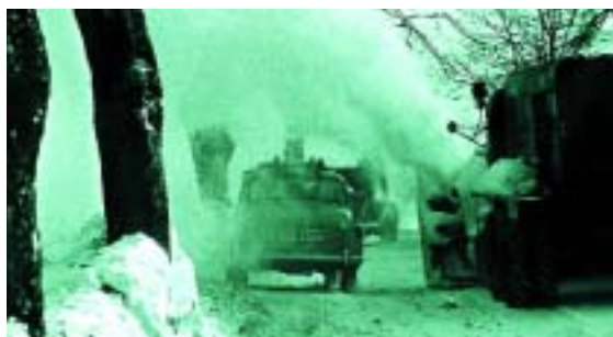
Fréza směrem na Bruntál - únor 1967
