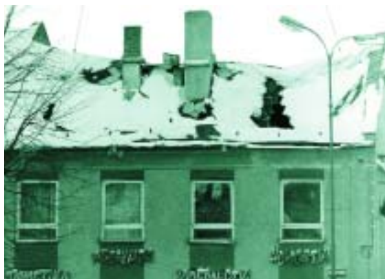
Pod tíhou sněhu praskla střecha v „Domě služeb“ na náměstí - únor 1967
