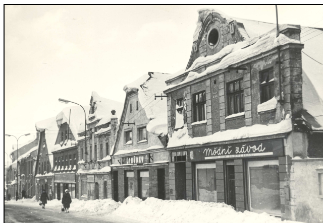
Pravá strana ulice Radniční před demolicí (MMR)
