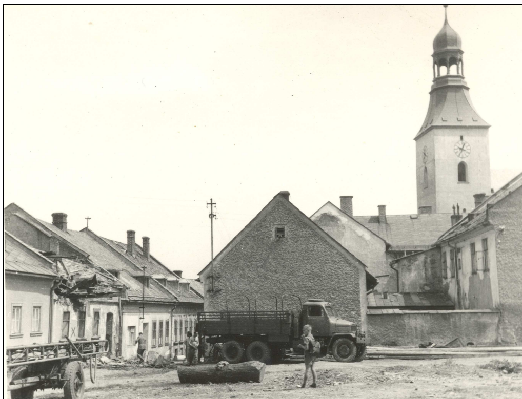
Demolice objektů na Jungmanově ulici, 1960 (MMR)
