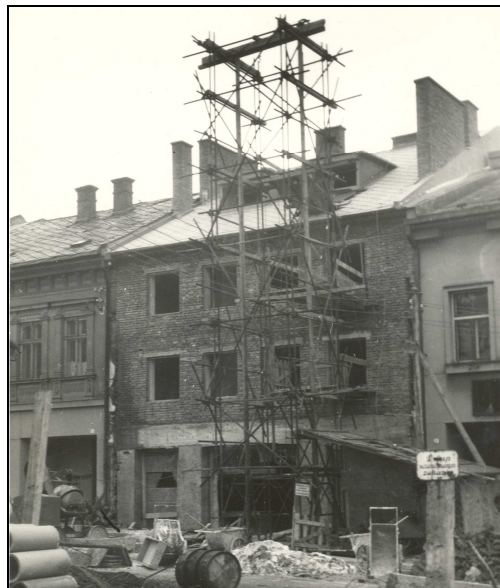
novostavba domu č. p. 217 , 60. léta 20. st.
